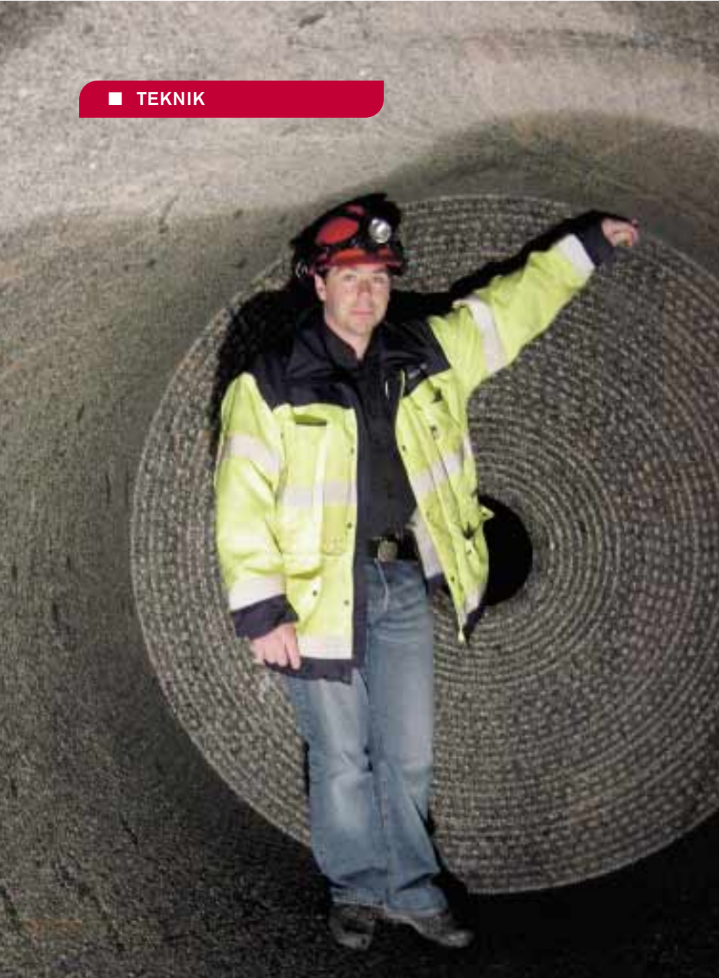
Rickard Karlzén visar upp det 15 meter långa horisontella deponeringshålet i Äspölaboratoriet. Foto: Berit Lundqvist
